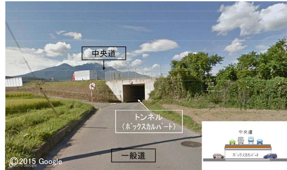
高速道路の下をトンネル(ボックスカルバート)で通る。
