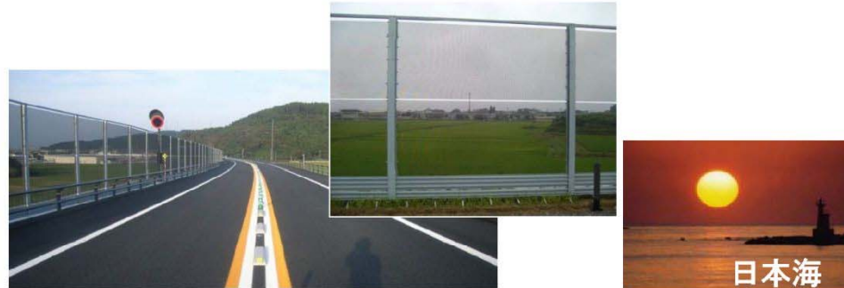
眺望性が良く、透過性を考慮した『樹脂ネット防風柵』を設置。鋼製の防風柵に比べ、mあたり約10%コスト削減
