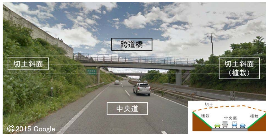
高速道路の上を通る。(交差する道路が橋梁構造)
